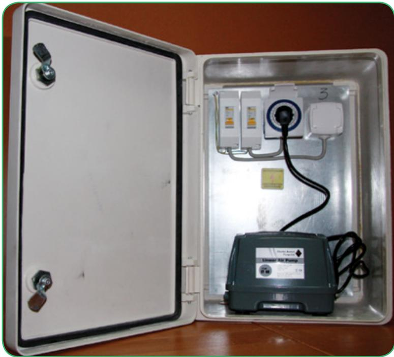
Рис. 6 ШУ FloTenk EC BioPurit
