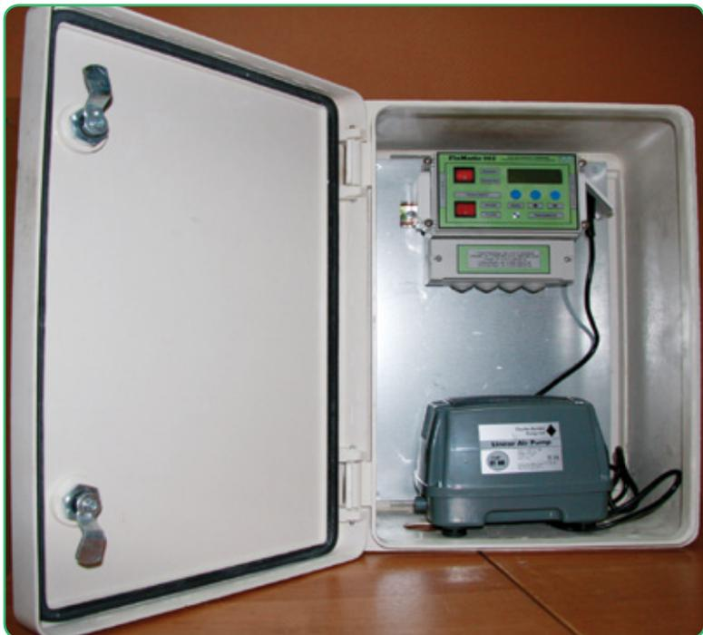
Рис. 7 ШУ FloTenk ACS BioPurit (с ПУ Flomatic)
