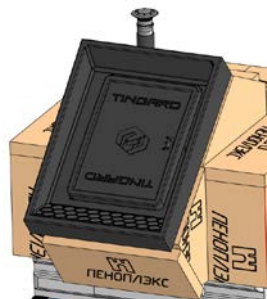
Рисунок 10 – Установка оклада
